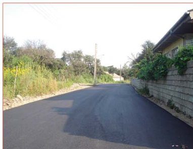
اجرای آسفالت (نهضت آسفالت)
